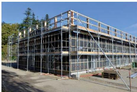
Avec garde-corps EXM et planchers acier - Longueur 9 m / Hauteur travail : 6m - Ø tubes 50mm, épaisseur 2 mm - Classe 4 (300 daN/m<sup>2</sup>) en travée de 3 m - Entraxe des cadres 0,83m. Réf. FDA7 MDS2
