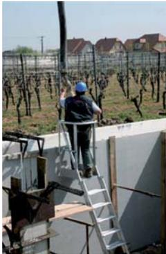
Hauteur d'accrochage de 1,92 à 4,05m avec crochets 200 mm. Conforme au Décret du 01/09/2004. Hauteur plancher 3.10 m. Largeur 0.60 m. Charge utile : 150 kg Réf. 18.021
