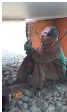
Fig. 6 Vêtement de soudeur complété d'un tablier et d'une coiffe ignifugés
