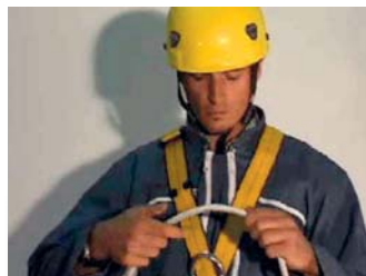
Fig. 2 Vérification visuelle de l'équipement avant utilisation
