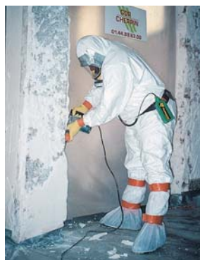
Fig. 8 Combinaison à usage unique lors de travaux de retrait d'enduits au plomb
