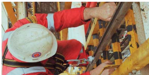
Fig. 10 Antichute mobile sur support d'assurance rigide
