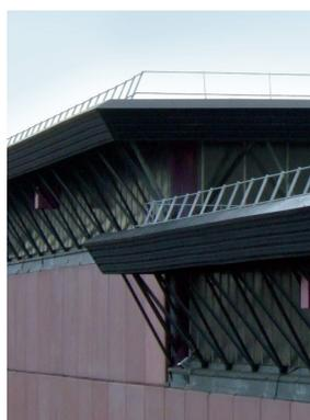
Pour fixation sur acrotère (acier, béton, pierre ou lisse filante), Protection des toitures terrasses non accessibles au public ou les terrasses techniques accessibles pour les opérations de maintenance.
